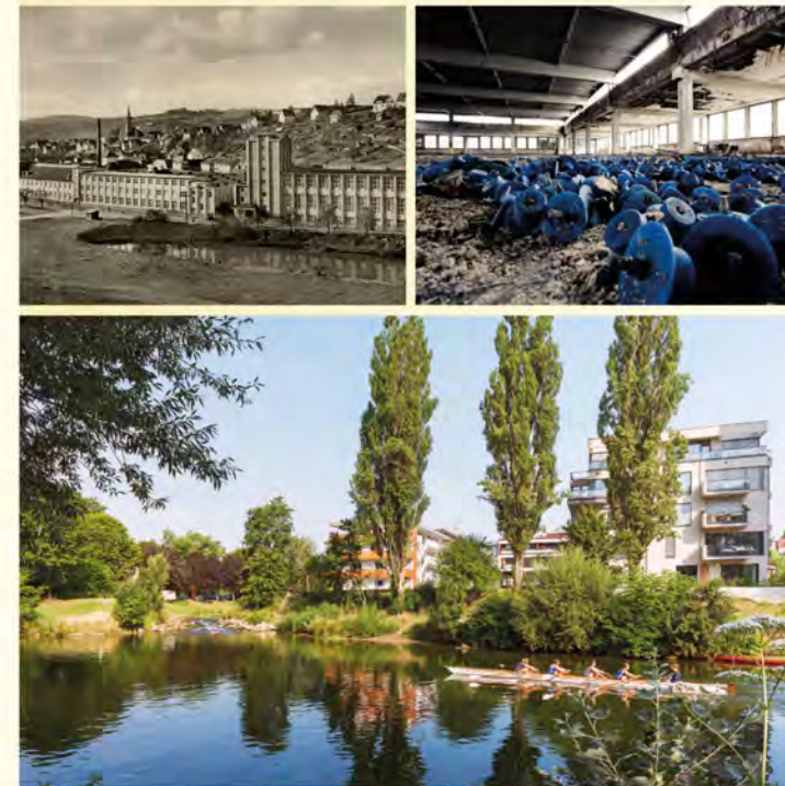
Abb. 7: Postkarte der Württembergischen Frottierweberei Egeria, um 1950. Abb. 8: Leerstehendes Industriegebäude der Egeria-Werke. Abb. 9: Die Alte Weberei, ein attraktives Stadtquartier ist entstanden.
